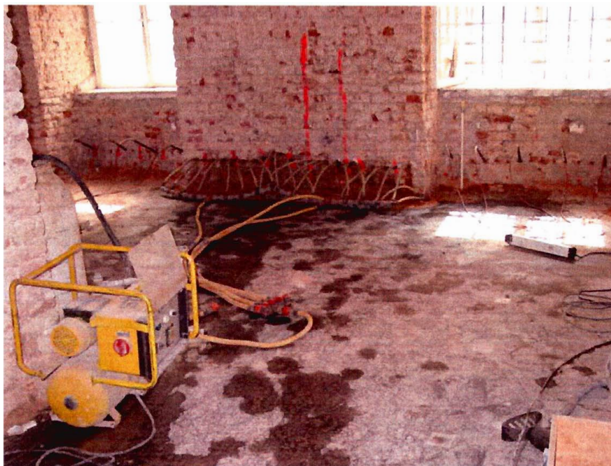
Bild 7: Injektionsmitteleinbringung mittels Impulssprühverfahren
