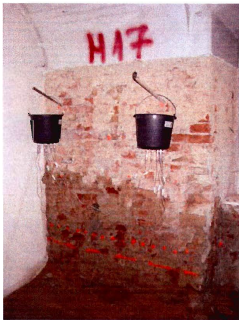
Bild 3: Bewässerung der Injektionsebene mittels spezieller Bewässerungseinrichtung
