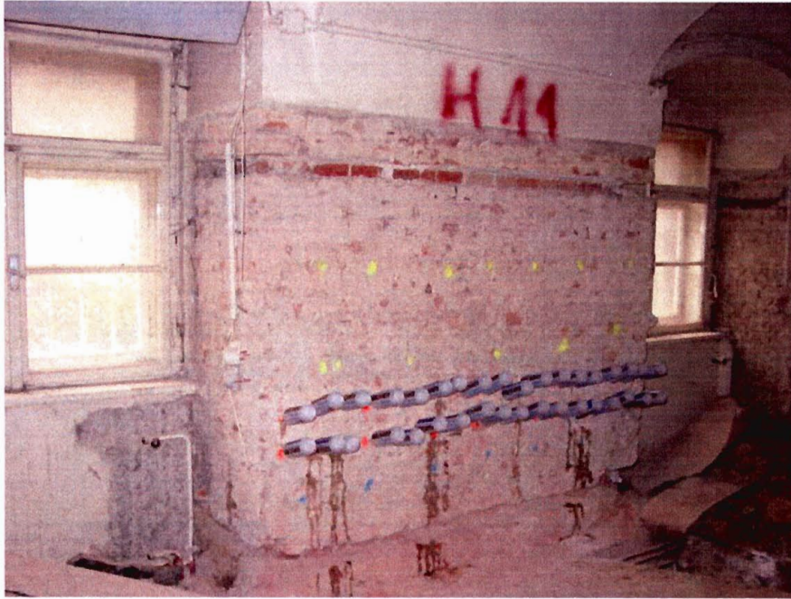
Bild 4: Injektionsmitteleinbringung mittels Injektionsflasche
