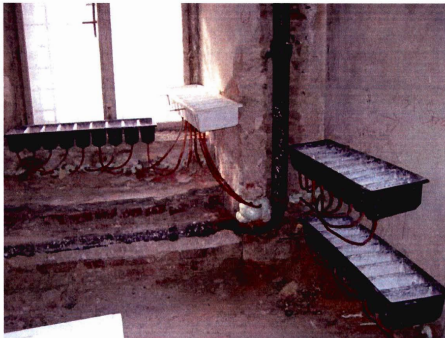
Bild 5: Injektionsmitteleinbringung mittels Hohldochtverfahren
