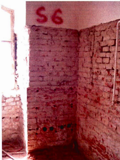
Bild 9: Mauerwerkspfeiler nach der Bohrkernentnahme
